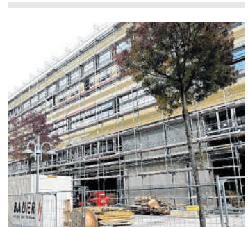
Die Fassade des neuen K1 Karrees am Neckartor. BILD: TRÖSTER
